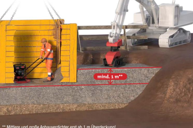
\*\* Mittlere und große Anbauverdichter erst ab 1 m Überdeckung!
