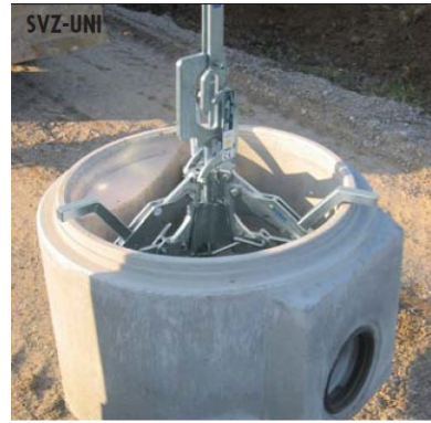
Bild 7: Schachtversetzzange (Probst)
