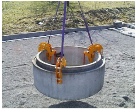
Bild 6: Schachtringgehänge (Probst)
