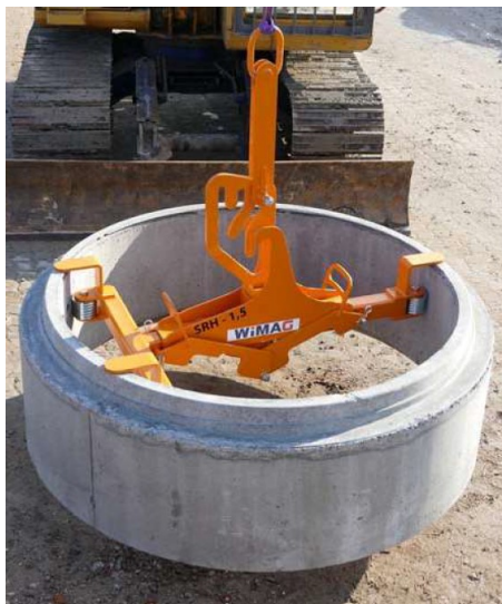
Bild 8: Schachtheber (WIMAG)
