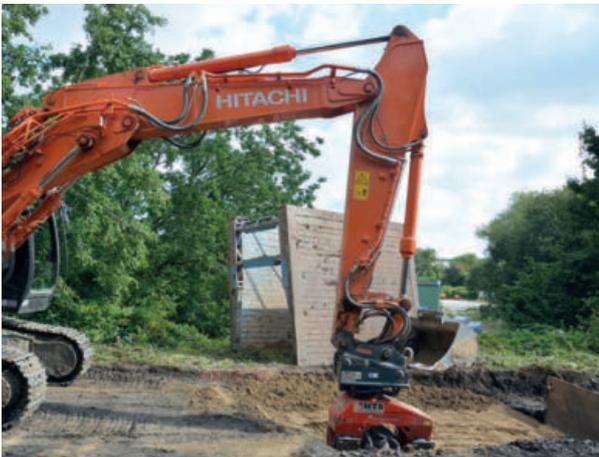
Das Überschütten der Rohrleitung muss so erfolgen, dass eine ausreichende Verdichtung gewährleistet ist, und die Rohre nicht beschädigt werden. Das schlagartige Einfüllen großer Erdmassen oder das Verdichten mit Fallgewichten ist nicht erlaubt. Geräte zum Ziehen des Verbaus dürfen dabei nicht auf, sondern nur neben der Leitungstrasse stehen.
