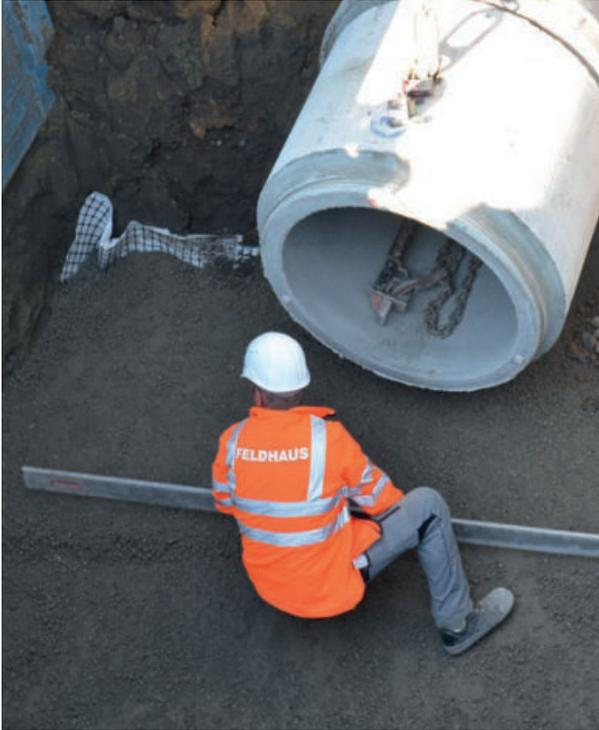
Die Schachtunterteile werden auf die höhengerecht und plan hergestellte Sohle (anstehender, geeigneter Boden, Austauschboden oder Beton) aufgesetzt. Gegebenenfalls sind zum Ausgleich von Unebenheiten eine dünne Sandschicht oder ein Frischmörtelbett vorher aufzubringen.
