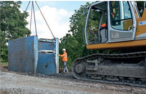
Wenn das Abböschern des Rohrgrabens nicht möglich ist, stützt und sichert ein Verbau die Wände des ausgehobenen Grabenabschnittes. Graben und Verbau müssen den Vorgaben der statischen Berechnung sowie den Unfallverhütungsvorschriften entsprechen und eine normgerechte Einbettung und Verdichtung im Bereich der Leitungszonen ermöglichen.
