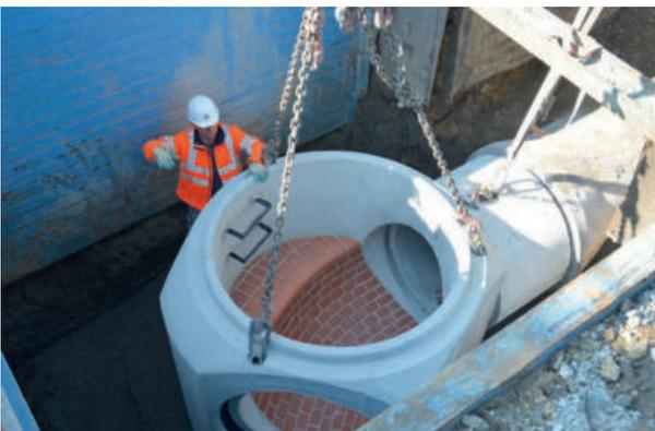
Für Abwasserkanäle und -leitungen sind nur Schachtbauteile nach DIN EN 1917 und DIN V 4034-1 zugelassen, sie haben Muffenverbindungen für Dichtungen aus Elastomeren. Lose mitgelieferte Gleitdichtungen werden bauseits auf die Spitzenden der bereits verlegten Schachtbauteile aufgezogen.
