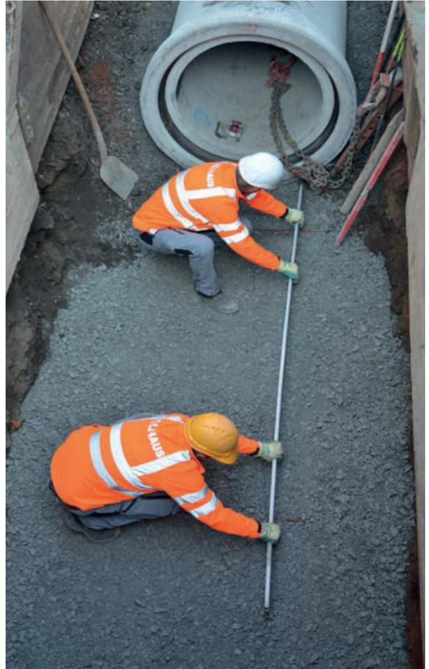
Die Grabensohle ist entsprechend dem Rohrleitungsgefälle herzustellen und während der Verlegung wasserfrei zu halten. Eignet sich der anstehende Boden nicht als Rohrauflager, muss der Boden ausgetauscht werden. Gegen Punktbelastungen sind für Rohre mit Glocke ausreichend große Muffenlöcher auszuheben. Bei Betonbettung liegt die Grabensohle entsprechend tiefer.
