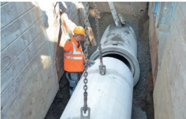
Mit Hebezeugen, die ein gleichmäßiges und feines Heben und Senken erlauben und unter Verwendung von Seilen, Gurten, C-Haken, Rohrgreifern o.ä. werden die Rohre und Formstücke in den Rohrgraben abgelassen.
