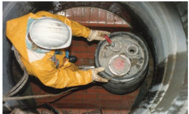
Die Prüfung kann mit Wasser oder Luftüberdruck durchgeführt werden. Die FBS empfiehlt für Rohre die Prüfung mit 100 mbar (Prüfverfahren LC für feuchte Betonrohre). Die Messergebnisse werden aufgezeichnet.
