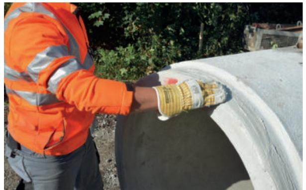
Dichtung und Gleitmittel sind aufeinander abgestimmt; **aus diesem Grund darf nur das vom Hersteller der Dichtung zugelassene Gleitmittel verwendet werden.** Es wird im Allgemeinen vom Rohrhersteller mitgeliefert. Das Gleitmittel ist bei Rohren mit werkseitig in der Muffe eingebauter Dichtung auf das Spitzende, bei Rohren mit Spitzendichtung in der Muffe satt aufzutragen.
