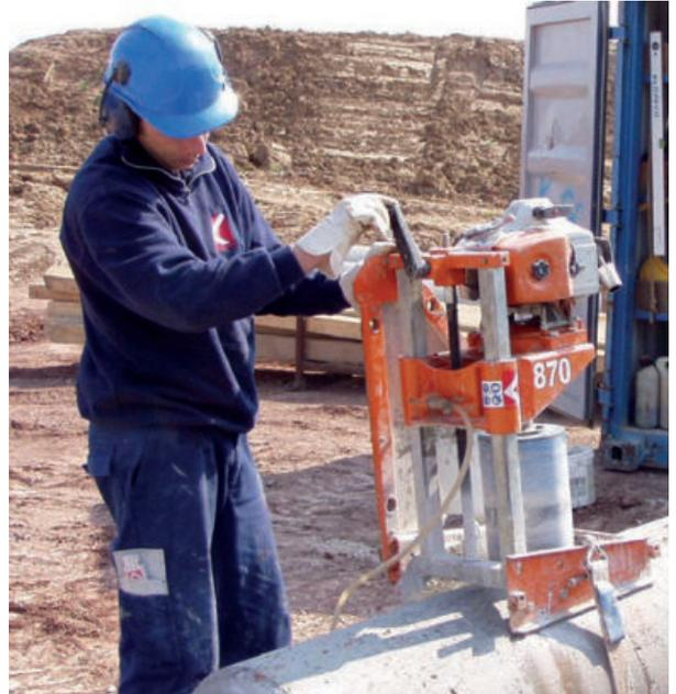
Die Herstellung von Hausanschlüssen sollte möglichst vor der Verlegung des Rohres erfolgen (s. FBS-Richtlinien für den Einbau). Die Herstellung der Öffnung wird mit einem Kernbohrgerät mit einer für das Anschlussystem passenden Bohrkronen durchgeführt. Der Durchmesser der Bohrkronen sollte aufgrund der Abnutzung ständig kontrolliert werden.
