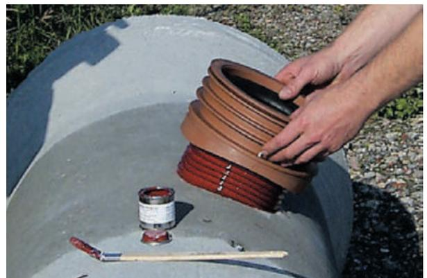
Der Schachtabschluss besteht in der Regel aus dem Schachthals (auch Konus genannt) und ggfls. Auflageringen zur Angleichung an die Straßen- bzw. Geländehöhe und der Schachtabdeckung. Bei niedrigen Überdeckungshöhen werden anstelle von Schachthälsen Abdeckplatten eingebaut.
