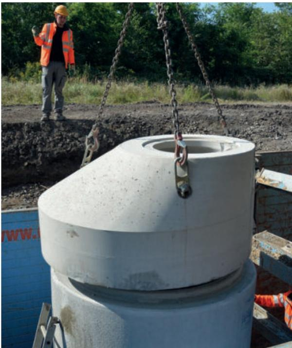
Abwasserkanäle und -leitungen sind, soweit technisch möglich, vor dem Einbetten und Verfüllen auf Wasserdichtheit zu prüfen. Die Verfüllung um den Schacht muss lagenweise eingebracht und gleichmäßig verdichtet werden.
