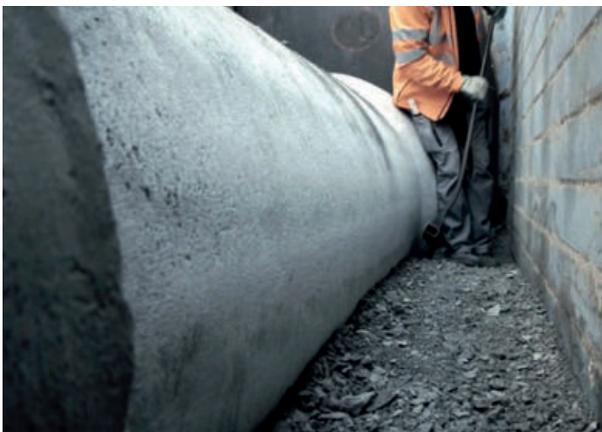
Nach dem Ausrichten wird das runde Rohr unterstopft und abgelegt. Dabei muss es über die gesamte Länge des Rohrschaftes gleichmäßig aufliegen. Danach wird die Bettung (Auflagerung) hergestellt. Dabei ist darauf zu achten, dass die Verdichtung des Bettungsmaterials in den Rohrzwickeln mindestens der unterhalb des Rohres entspricht. Die Bettung muss mit den Vorgaben der statischen Berechnung übereinstimmen.
