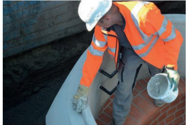
Das Gleitmittel muss auf die der Dichtung gegenüberliegende Betonkontaktfläche aufgetragen werden. Dabei darf nur das vom Hersteller der Dichtung zugelassene Gleitmittel verwendet werden. So geschmiert, lassen sich die Schachtteile leicht zusammenfügen. Für eine gleichmäßige, vertikale Lastübertragung, i. d. R. an den äußeren Stoßfugen, ist zu sorgen (z.B. durch geeignete, zugelassene Übertragungselemente oder durch Vermörtelung).
