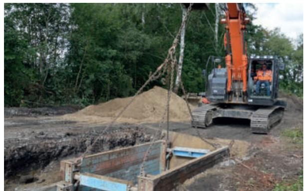
Nach evtl. Wasserdichtheitsprüfung folgt das Einbetten. In der Leitungszone bis 30 cm, mindestens aber 15 cm über dem Rohrscheitel bzw. 10 cm über der Glocke wird gut verdichtungsfähiges Material eingebaut. Der Verbau wird schrittweise gezogen, so kann gegen den anstehenden Boden verdichtet werden. **Das nachträgliche Ziehen des Verbaus, z.B. bei Spundwänden, ist statisch abzusichern.**
