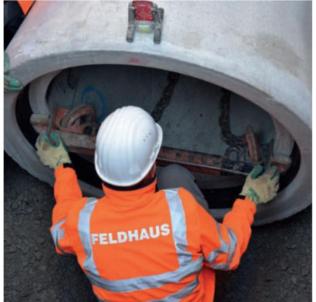
Das einzubauende Rohr wird **frei hängend** in die Muffe des bereits verlegten Rohres eingeführt, damit sich die Rohrverbindung zwängungsfrei zentrieren kann. Danach wird es in Höhe und Richtung nach Plan ausgerichtet und unterstopft, so dass eine über die gesamte Rohrlänge gleichmäßige Auflagerung entsteht. **Verlegekorrekturen durch Drücken, Schieben oder Schlagen mit dem Baggerlöffel sind verboten.**
