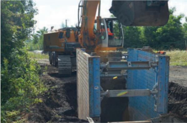
Nach Abstecken der Kanaltrasse wird der Rohrgraben unter **Beachtung der Mindestgrabenbreite** nach DIN EN 1610 und DIN 4124 ausgehoben. Verdichtungsfähiger Boden wird – soweit möglich – neben dem Rohrgraben zwischengelagert. Zur Verfüllung nicht geeignetes Material wird abtransportiert.
