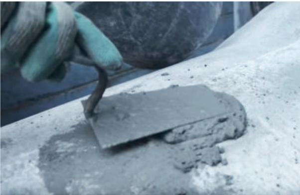
Bei Rohren und Schächten, bei denen Transportanker verwendet werden, müssen die Ankermulden dauerhaft und korrosionssicher verschlossen werden und dürfen die Eigenschaften des Bauteils nicht beeinflussen.
