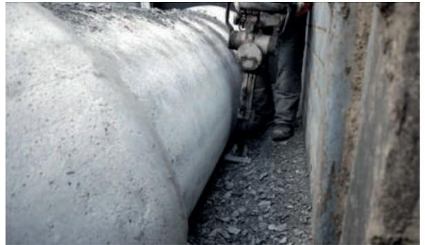
Bei ungeeigneten Böden, starker Grundwasserströmung oder aus statischen Gründen kann eine Bettung auf Beton (mindestens C12/15) erforderlich sein. Der Stützbeton muss satt am Rohr anliegen. In DWA-A 139 wird empfohlen, die Betonbettung über die gesamte Grabenbreite durchzuziehen. Dabei ist der Beton gegen den Verbau abzustellen sofern er nicht bis gegen den gewachsenen Boden eingebracht werden kann. Der Rohrgraben darf erst nach Erhärten der Betonbettung verfüllt werden.
