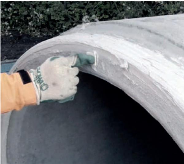
Zur Erhaltung der Beweglichkeit der Verbindung ist ein Stoßfugenspalt von mindestens 5 mm einzuhalten. Um diesen Stoßfugenspalt einzuhalten ist bauseits ein Anschlagstopp einzubauen.
