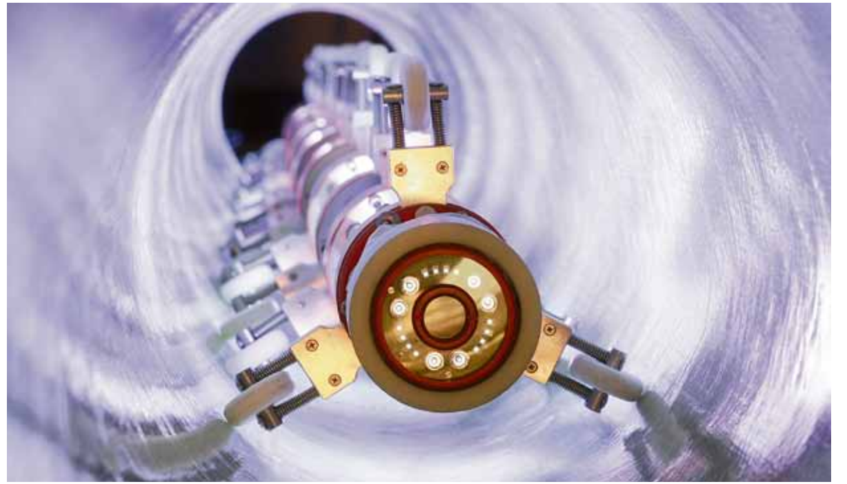
Sanierung mittels GFK-Schlauchliner. Lichtquelle 8x400W in einem Liner DN 300.
