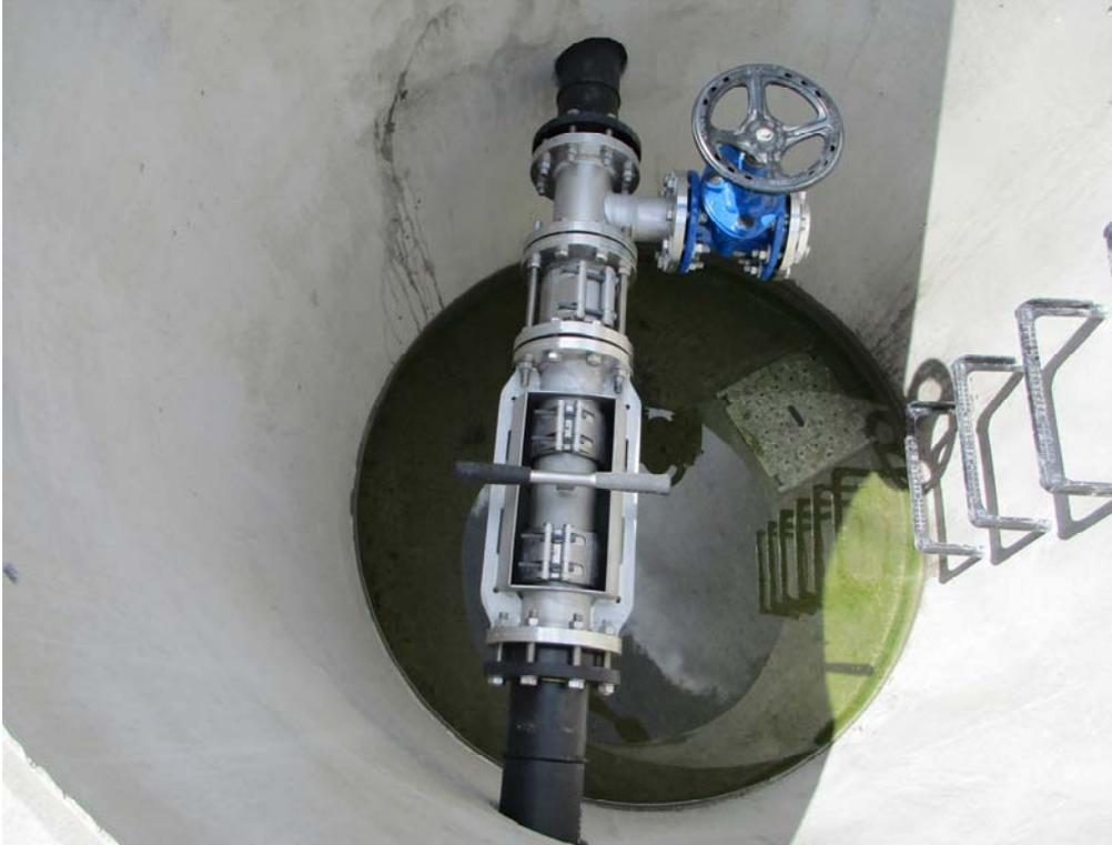
Im Betonwerk SCHNURRER wurden die Installationen in den Schachtbauwerken vormontiert.
