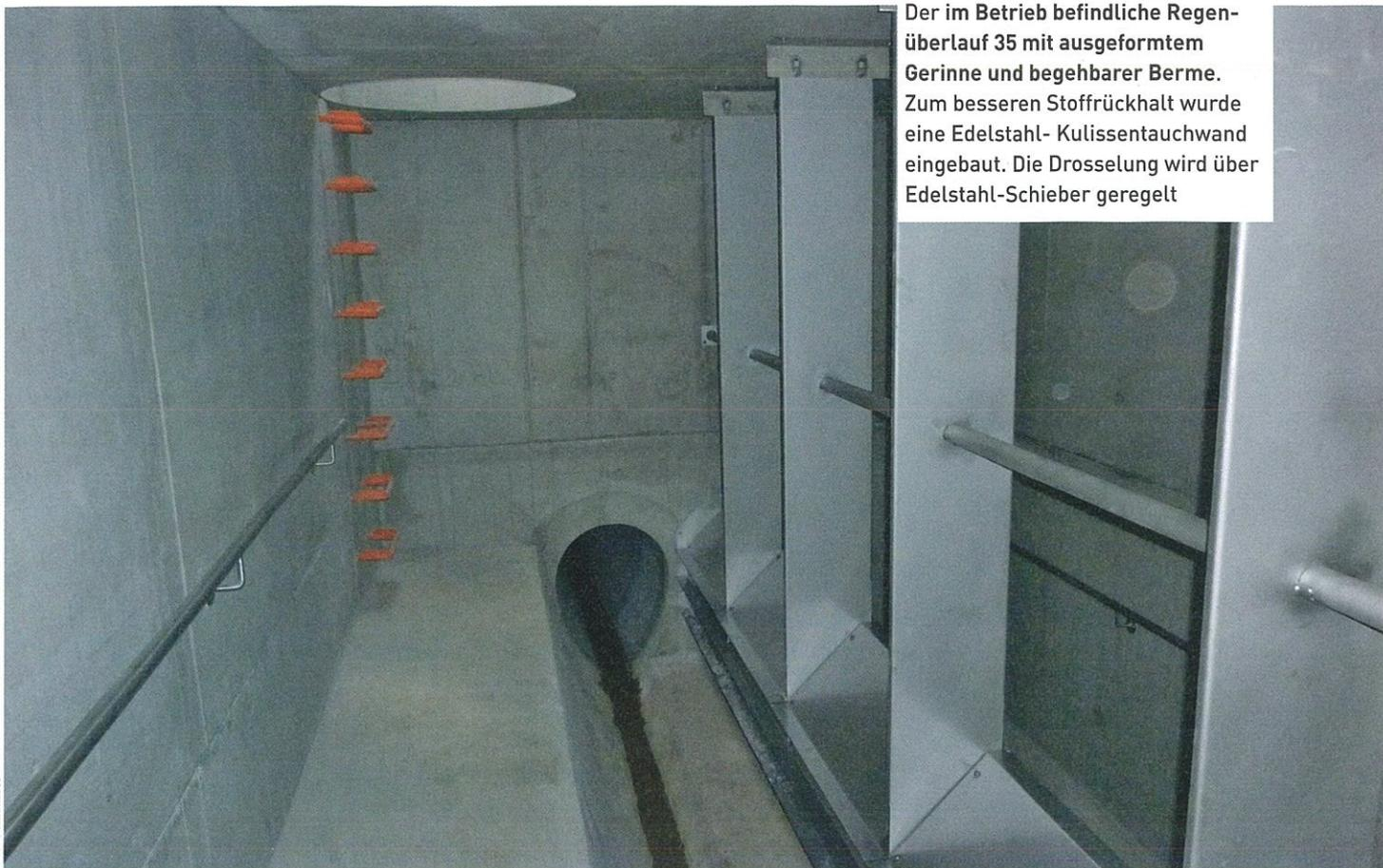
Der im Betrieb befindliche Regenüberlauf 35 mit ausgeformtem Gerinne und begehbare Berme. Zum besseren Stoffrückhalt wurde eine Edelstahl-Kulissentauchwand eingebaut. Die Drosselung wird über Edelstahl-Schieber geregelt
