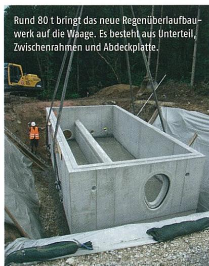
Rund 80 t bringt das neue Regenüberlaufbauwerk auf die Waage. Es besteht aus Unterteil, Zwischenrahmen und Abdeckplatte.
