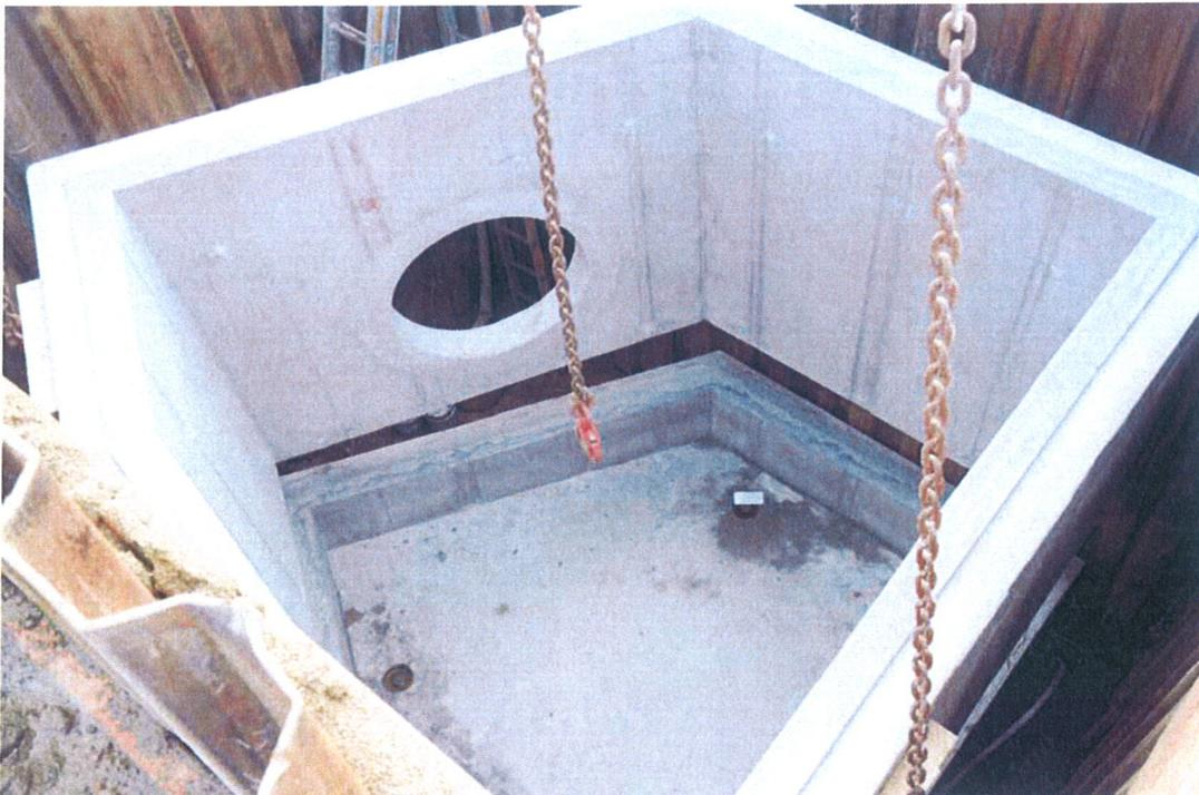
Die exakte Nut- und Federfugenkonstruktion und ein spezieller Zwei-Komponentenkleber sorgten für eine kraftschlüssige und wasserdichte Verbindung.
