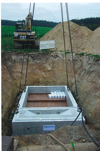
Rund 65 t bringt der Fertigteilsschacht auf die Waage
