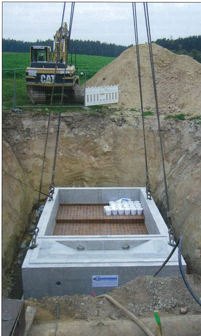
Rund 65 t bringt der aus drei Einzelteilen bestehende FBS-Fertigteilschacht auf die Waage. Foto: Schnurrer
