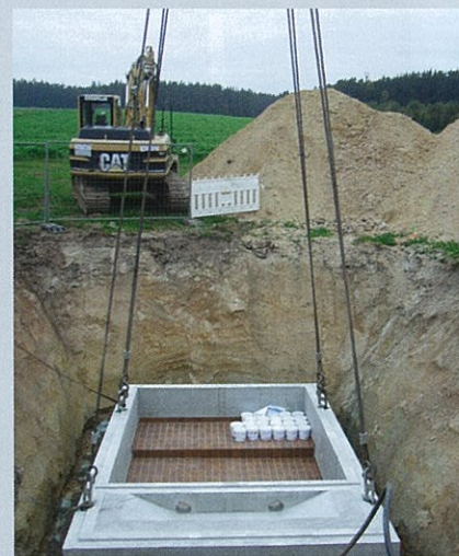
Bild 2: Rund 65 t bringt der aus drei Einzelteilen bestehende FBS-Fertigteilerschacht auf die Waage
