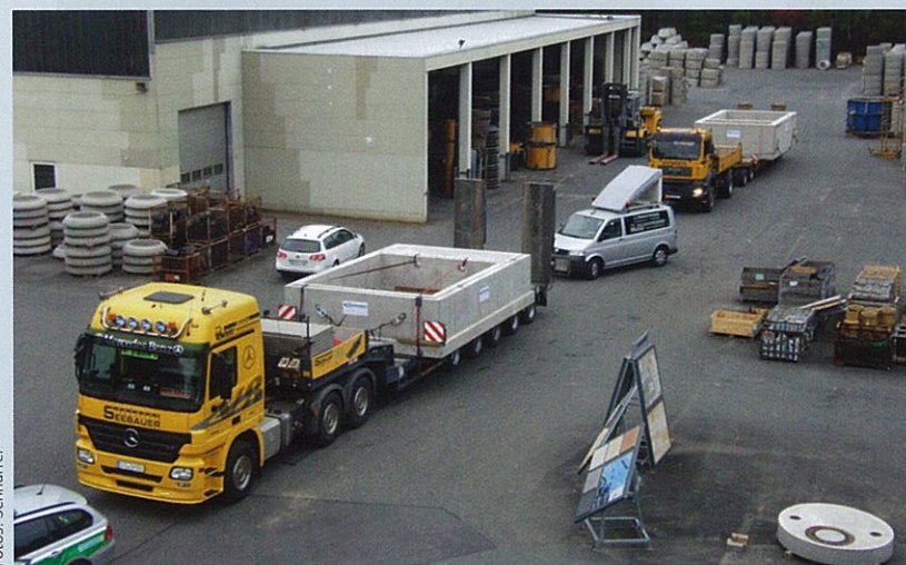
Bild 1: Die Fertigteile wurden nach terminlicher Absprache zur Einbaustelle geliefert. Aufgrund der Abmessungen der Einzelelemente erfolgte der Transport im Konvoi mit Polizeibegleitung
