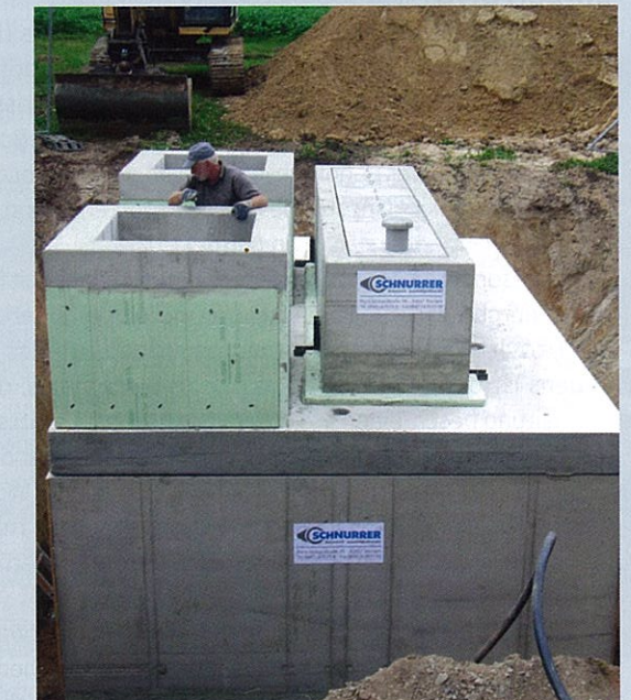
Bild 4: Eine Deckenplatte ausgestattet mit zwei isolierten Einstiegsdomen und einer aufgesetzten Schalldämpferwanne bildet den Abschluss des Schachtbauwerks
