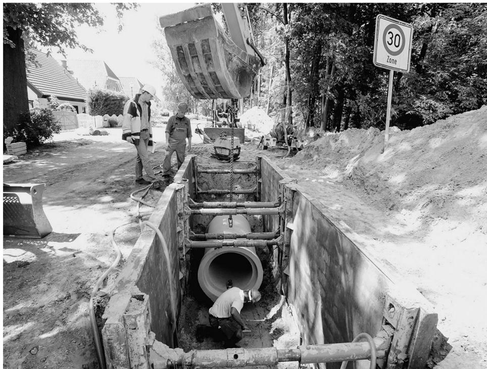
Das Zusammenwirken von Bettung, Bauteil und Verfüllung ist Grundlage für die Stand- und Betriebssicherheit von Rohrleitungen.
