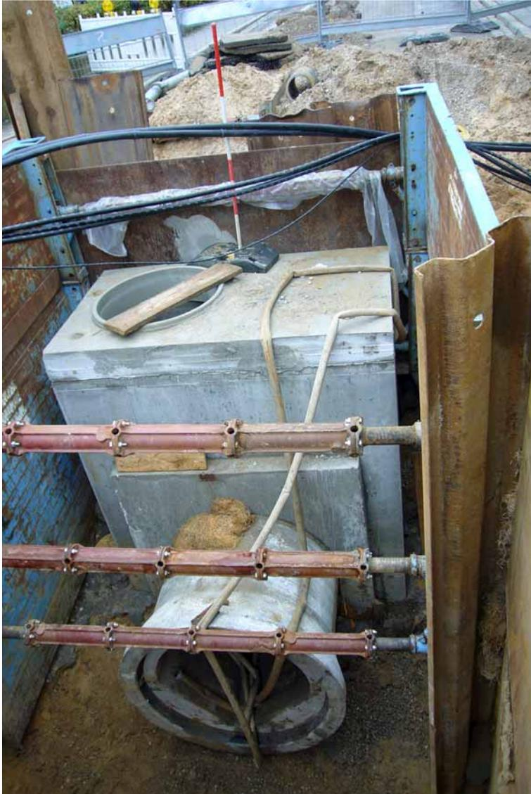
Die Schachtbauwerke in Kompaktbauweise werden auf die Rohrquerschnitte abgestimmt und ebenfalls in FBS-Qualität gefertigt.
