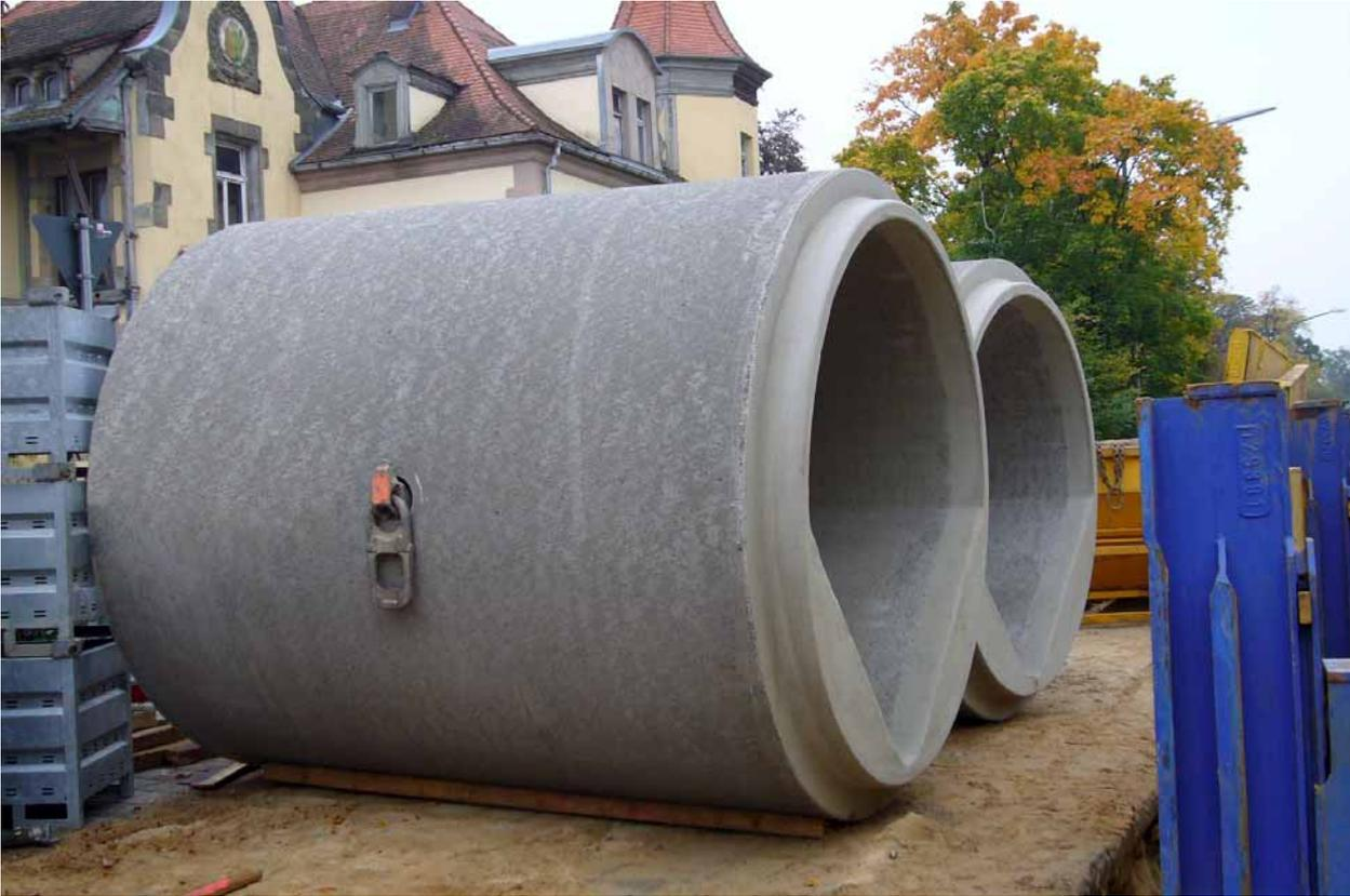
Insgesamt rund 300 m Stahlbetonrohre mit Drachenquerschnitt hat die J. SCHNURRER GmbH & Co. KG in FBS-Qualität nach Neumarkt in der Oberpfalz geliefert.
