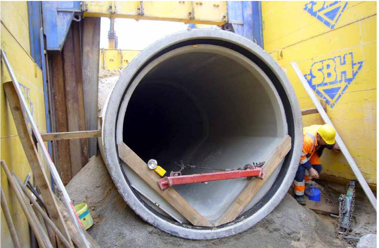
Eine in die Muffen fest eingebaute Dichtung erleichtert den Einbau und sorgt für zuverlässige Dichtigkeit in den Verbindungen.
