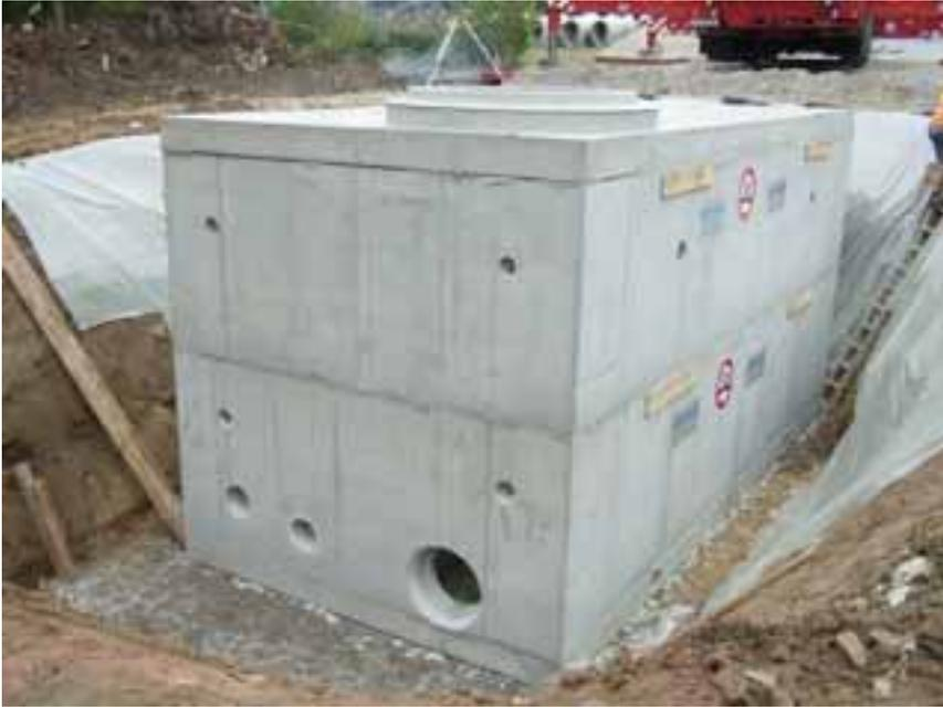
Rund 80 t bringt das neue Regenüberlaufbauwerk auf die Waage. Es besteht aus Unterteil, Zwischenrahmen und Abdeckplatte.
