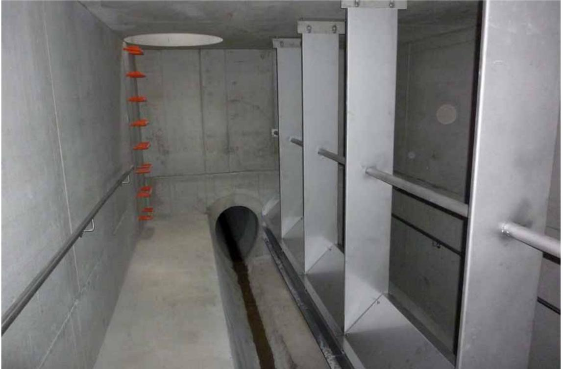
Der im Betrieb befindliche Regenüberlauf 35 mit ausgeformtem Gerinne und begehbare Berme. Zum besseren Stoffrückhalt wurde eine Edelstahl- Kulissentauchwand eingebaut. Die Drosselung wird über Edelstahl-Schieber geregelt..
