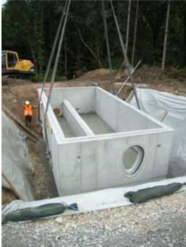
Eine spezielle Nut- und Federkonstruktion sorgt für ein passgenaues Zusammenfügen der Bauteile bei der Montage.
